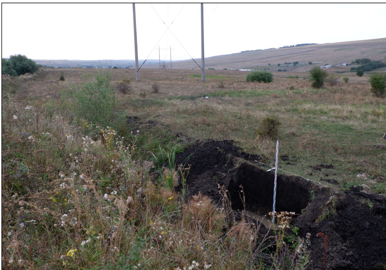
Рис. 51. Карачаево-Черкесская Республика. Зачистка после окончания работ. Общий вид. Вид с юго-востока.
